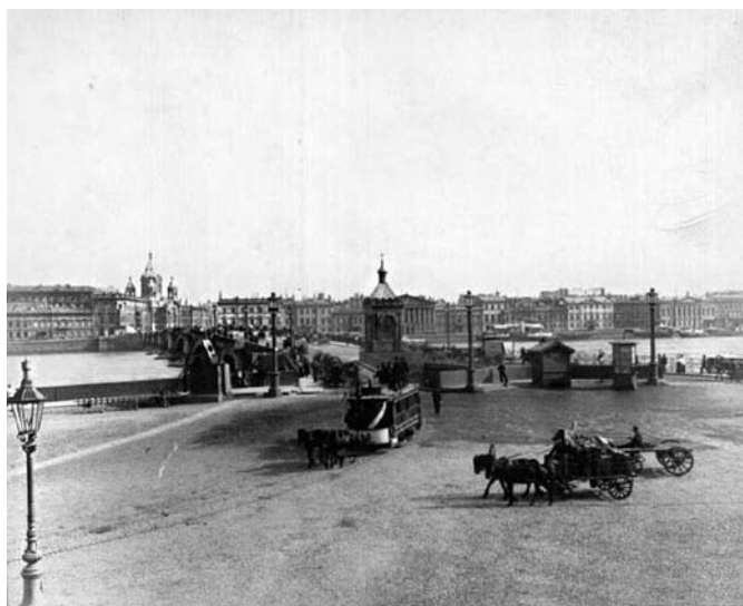
Вид на Николаевский (Благовещенский) мост. Фотография. 1913 г.
